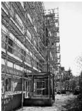
Eingerüstete Fassade Chimligasse 7 und 9
