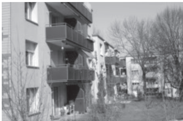
Balkonfassade Unterer Rain 2 + 4
